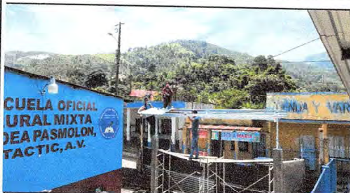
Foto 3: SUSTITUCIÓN DE PORTÓN Y ENTECHADO POR DETERIORO.
