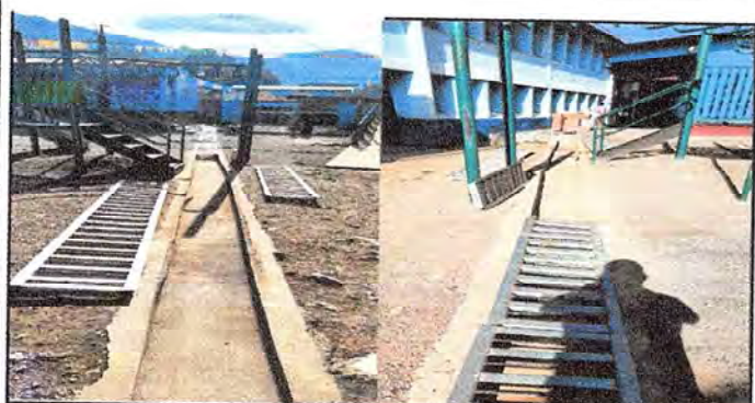
Foto 5: SUSTITUCIÓN DE REJILLAS EN CUNETAS POR DETERIORO EN ENTRADA AL ESTABLECIMIENTO.
