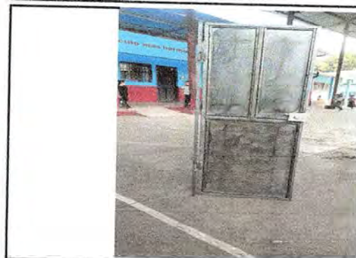
Foto 2: SUSTITUCIÓN DE PUERTA DE MADERA POR METAL POR DETERIORO.
