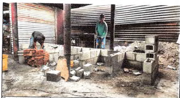
Foto 6: SUSTITUCIÓN DE POLLETON Y CHIMENEA POR DETERIORO.
