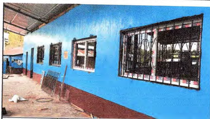
Foto 4: SUSTITUCIÓN DE VENTANAS POR DETERIORO.
