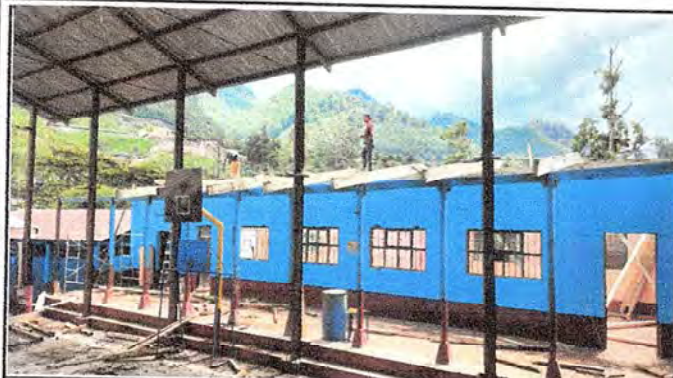
Foto 1: SUSTITUCIÓN DE LÁMINAS Y ESTRUCTURAS METÁLICAS POR DETERIORO
